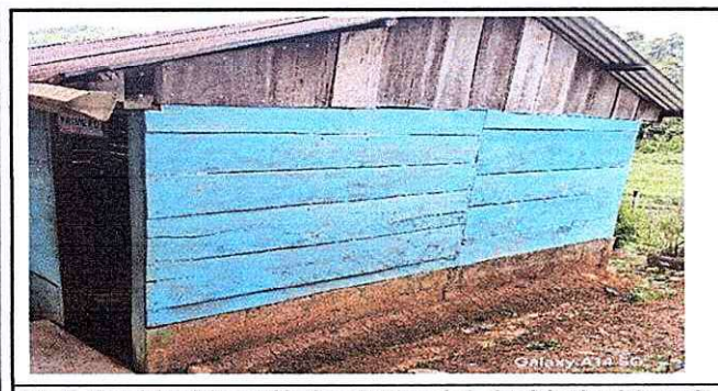
Foto 5. Vista lateral de cambio de estructura de techo del aula a intervenir.
