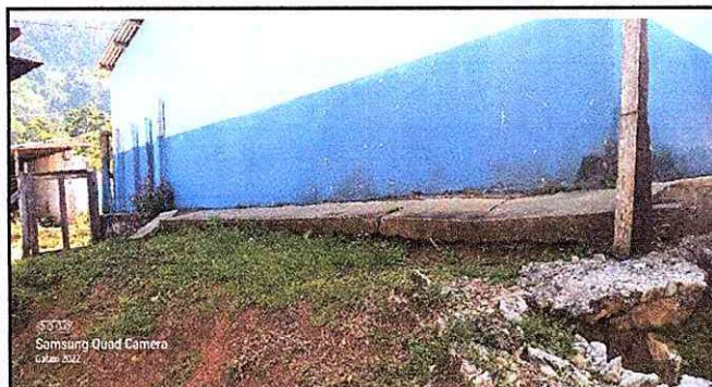
Foto 3. Vista Frontal de banqueta a intervenir.
