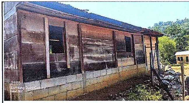
Foto 4. Vista lateral de aula a intervenir.
