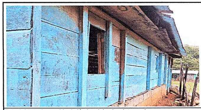
Foto 6. Vista de cambio de lámina del aula a intervenir.
