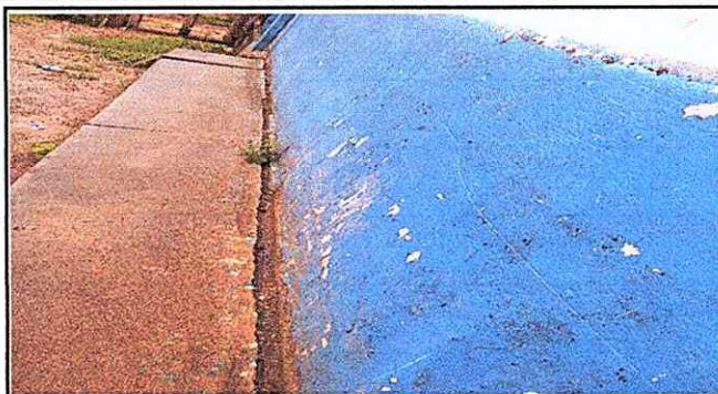
Foto 2. Rehabilitación de banqueta
